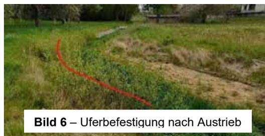
**Bild 6 – Uferbefestigung nach Austrieb**
