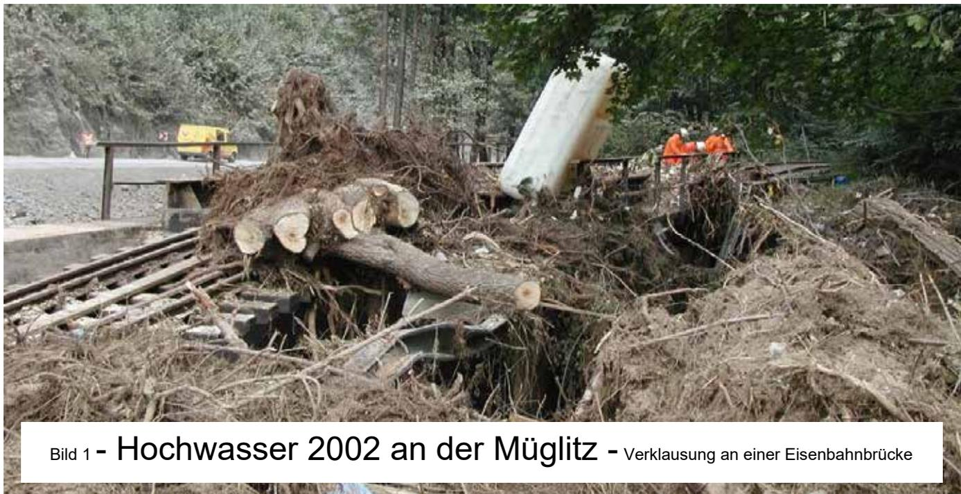
**Bild 1 - Hochwasser 2002 an der Müglitz - Verklausung an einer Eisenbahnbrücke**
