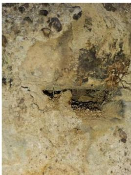
**Abbildung 5: Detailansicht Loch im Mauerwerk, potenzieller Lebensraum Fledermäuse und Brutvögel**
